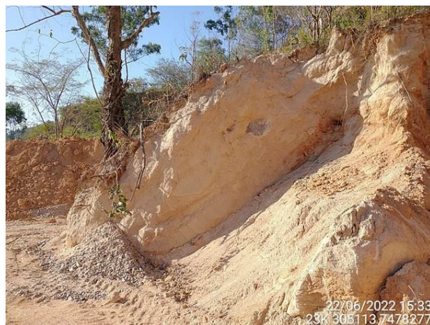
Foto 6 – Corte realizado no talude para a extração de solo e rocha. (Data: 22/06/2022).
