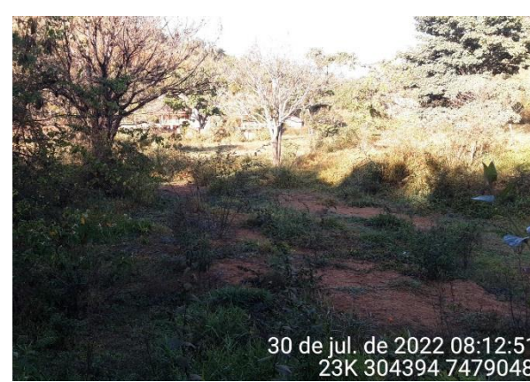
Foto 12 – Drenagem com acúmulo de sedimentos. Ponto 5. (Data: 30/07/2022).
